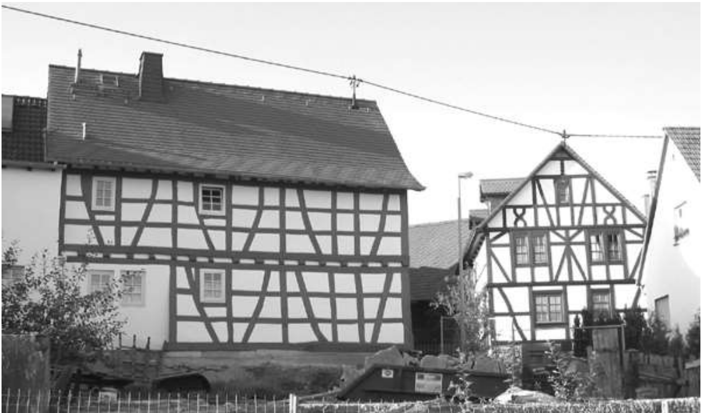
Ehemaliges Haus Kilb am Gasberg
