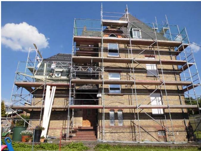
Die Dachdecker hatten einen Kran aufgestellt, um das asbesthaltige Material der Dacheindeckung ohne Probleme umweltgerecht entfernen, einpacken und entsorgen zu können. Dabei konnte immer nur so viel Dachfläche abgedeckt werden, wie am selben Tag auch wieder neu aufgeschalt und mit Folie abgedeckt werden konnte, damit das Dach am Abend wieder dicht war – siehe Foto links).
