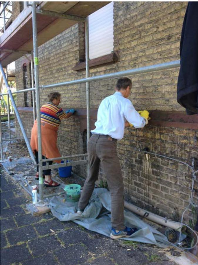
Nutzung der Gerüstzeit die Maurer am Werk. Jede Mauerfuge wurde auf Festigkeit geprüft, loses Material herausgekratzt und neu verfugt. Es waren
