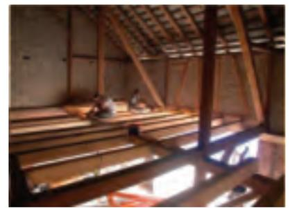
Erweiterung der Deckenbalken für ein neues Dachgeschoss
