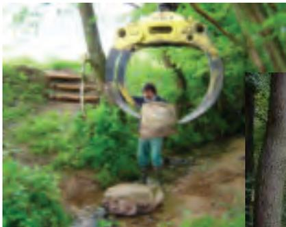
Foto oben: Schweres Gerät hilft beim Setzen der Furtsteine im Josbach
