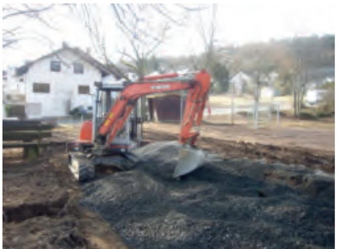
Drainage-Schotter wird in die ausgekofferte Spielfläche eingebracht
