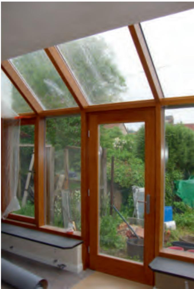
*Innenansicht auf die Pfosten-Riegel-Konstruktion aus heimischer Eiche (das Tageslicht von hinten hellt den gesamten Verkaufsraum auf).*
