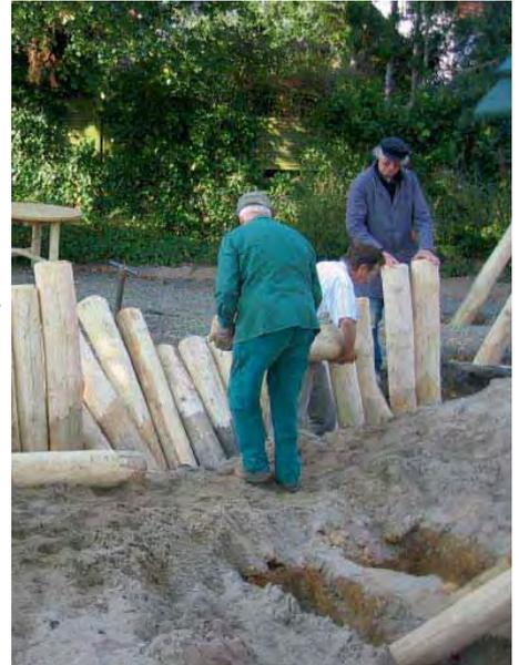
Die Palisaden für die Sandspielfläche werden gesetzt (26.9.2008)
